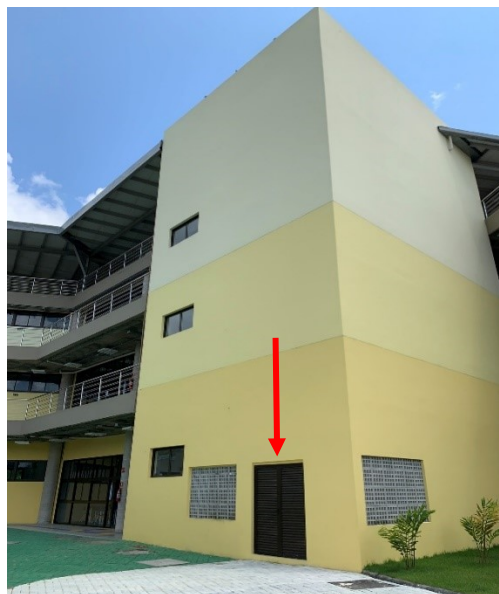
Foto do espaço 4 (“almoxarifado da reitoria”)
