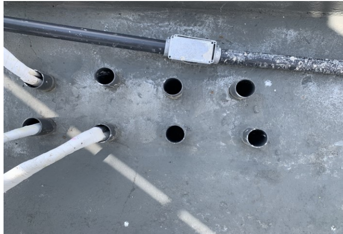
Imagem externa da laje (teto) do espaço 1
