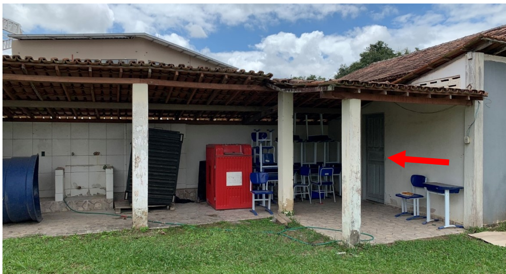
Foto do espaço 6 (“novo depósito”) com objetos em área externa e interna
